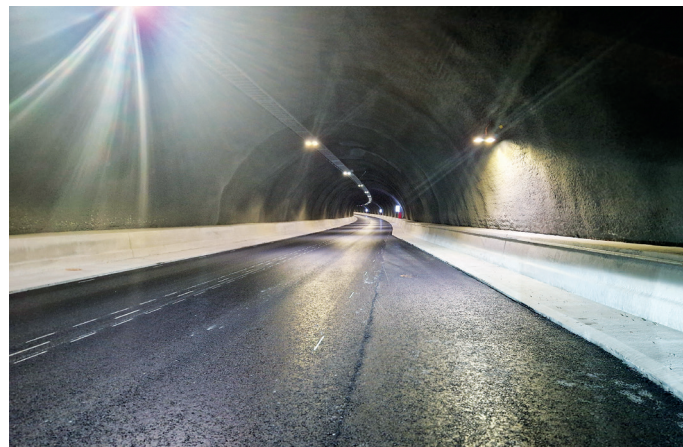
En svakhetsone i tunnelen gjorde at et parti på 70 meter måtte støpes ut med en meter tykk betong og omfattende armering.
