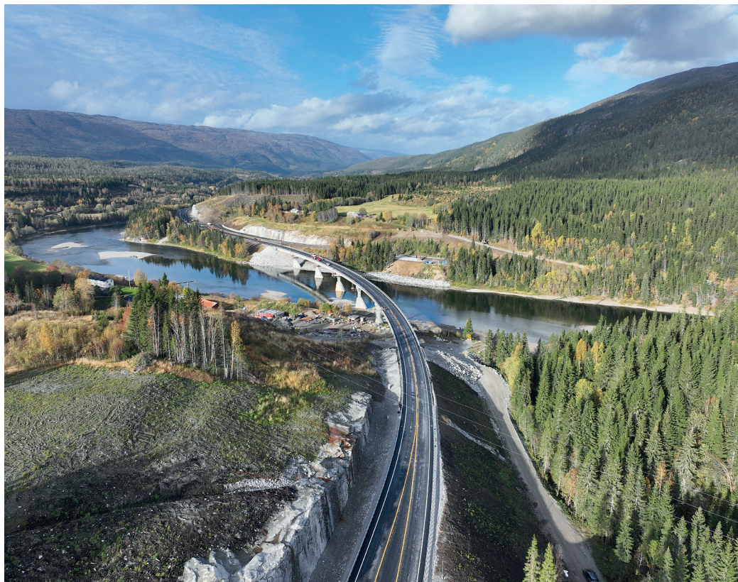
Valryggen bru er en betongkassebru på 387 meter fordelt på sju spenn som krysser Vefsna rett sør for Trofors. Varierende horisontal- og vertikalkurvatur krevde høy presisjon i utførelsen som ble gjort av HAK Entreprenør.
