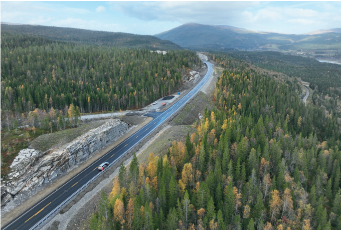
Med strekningen Svenningelv – Lien er siste parsell av den omfattende utbyggingen av E6 Helgeland ferdig etter 10 års sammenhengende anleggsarbeider. Dronefoto: Statens vegvesen
