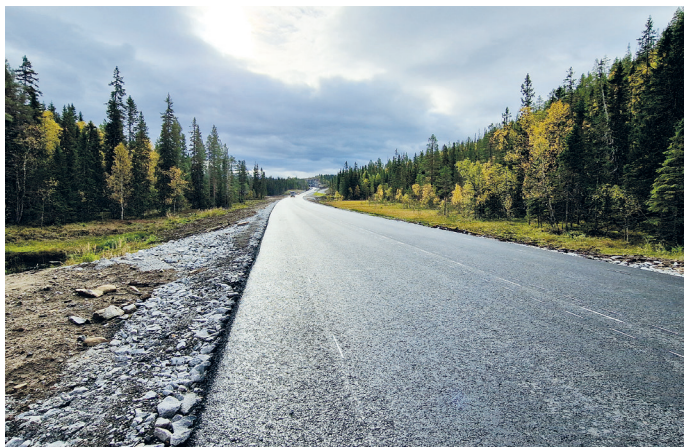
Denne delen av strekningen er den første E6-strekningen her til lands hvor veien er lagt flytende oppe på myr.
